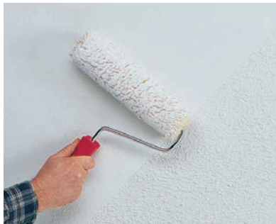
1. Структурную штукатурку нанести малярным валиком или плоской кистью.
