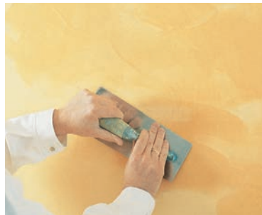
2. Шпаклевку нанести венецианским шпателем из нержавеющей стали на поверхность неровно, в виде пятен. Образующиеся при этом углубления, создают (при нанесении финишного покрытия) венецианский эффект.
