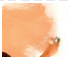
3. На высохшую штукатурку нанести лазурь плоской кистью и сразу растереть вдоль и поперек.
