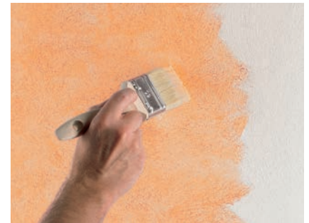
3. На высохшую штукатурку нанести лазурь плоской кистью и сразу растереть вдоль и поперек.
