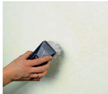
2. Еще влажную штукатурку растереть щеткой полукруглыми движениями вдоль и поперек.
