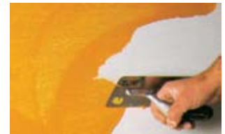
Нанесение базового слоя
